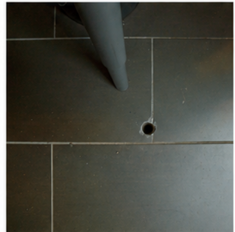
Perçement précis en dalle ou revêtement intérieur sans dégradation.
