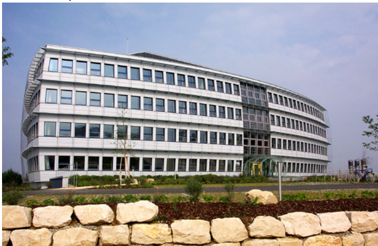
Bureau passif à Ulm. Architectes: oehler faigle archkom
