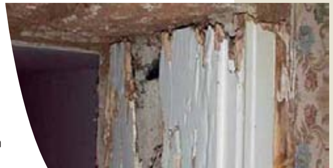
Attaques sur un montant de porte
