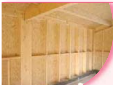
Murs à ossature bois
