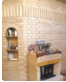
Mur intérieur en briques de terre crue
